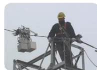
机器人机械式除冰： 铁塔结冰后安装机器人困难 危险性高
