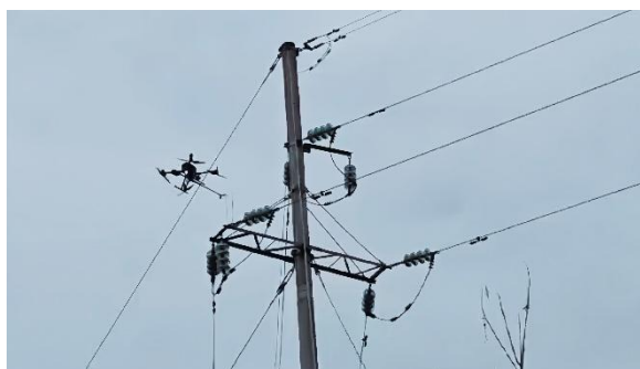
检测耐张绝缘子串
