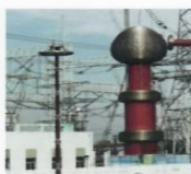
图1 1500kV 工作现场
