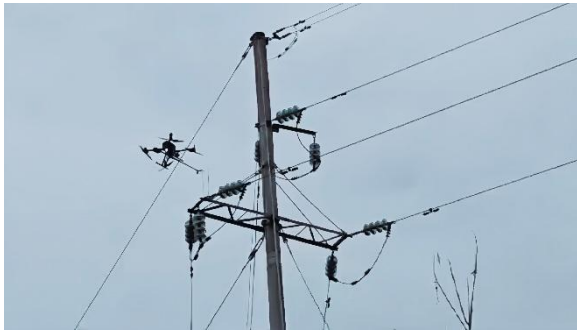
检测耐张绝缘子串
