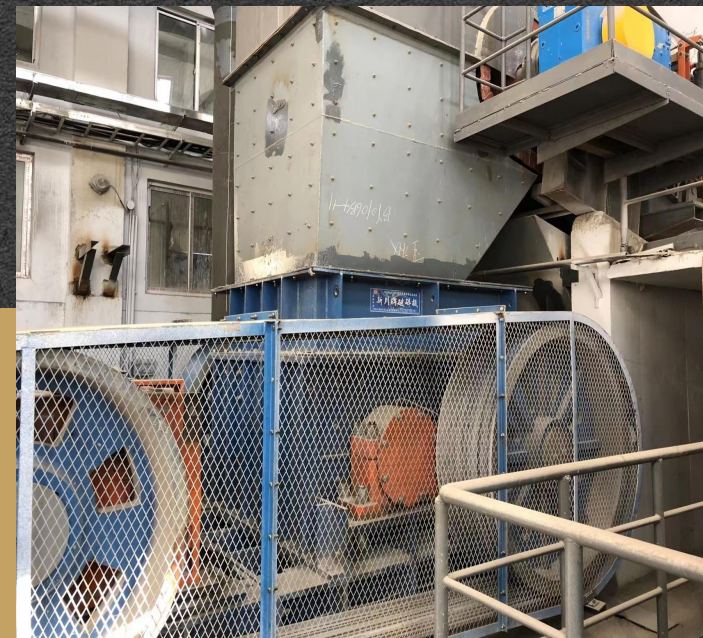
本溪钢铁某矿业集团
