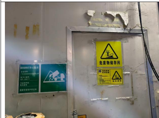
危险废物暂存间
