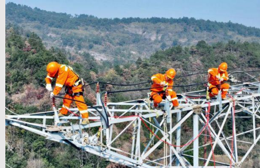
直流融冰： 操作复杂、能源损耗大
