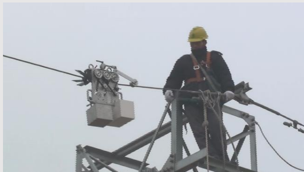
机器人机械式除冰： 铁塔结冰后安装机器人困难、危险性高
